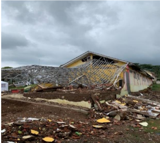
Gambar 9. Runtuh Pada Rangka Atap dan Bangunan SMKN 1 Cugenang Sumber: Peneliti
