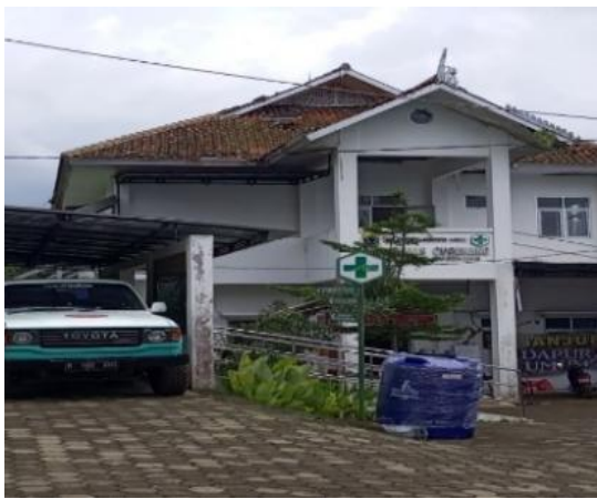
Gambar 2. Kerusakan Pada Genting Puskesmas Cugenang
