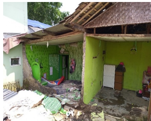
Gambar 5. Rumah Semi Permanen Mengalami Keruntuhan Dinding di Desa Benjot
