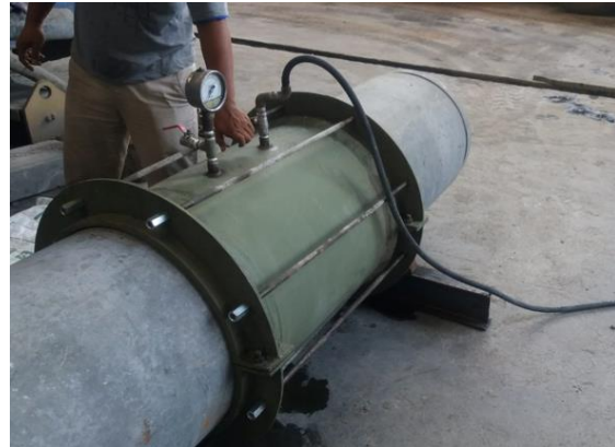
Gambar 12. Pelaksanaan test kekedapan air , pada sambungan tidak bocor di tekanan 2,5 Bar dalam waktu 3 menit
