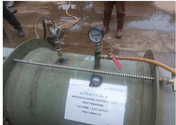
Gambar 27. Pelaksanaan test dilapangan sebelum pipa dilakukan pemasangan Sumber Lab Dusaspun
